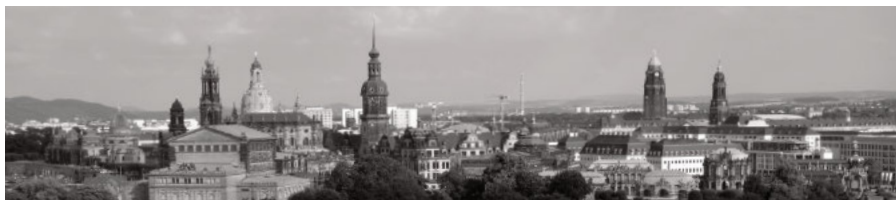
24 Blick vom Haus der Presse auf die Dresdner Altstadt
